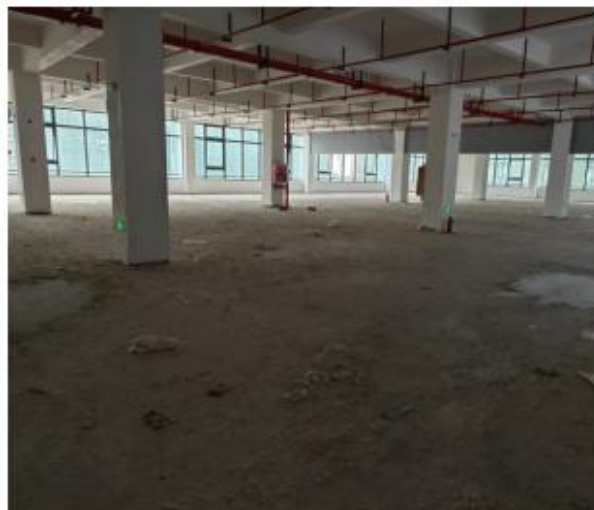
空置厂房现状 403
