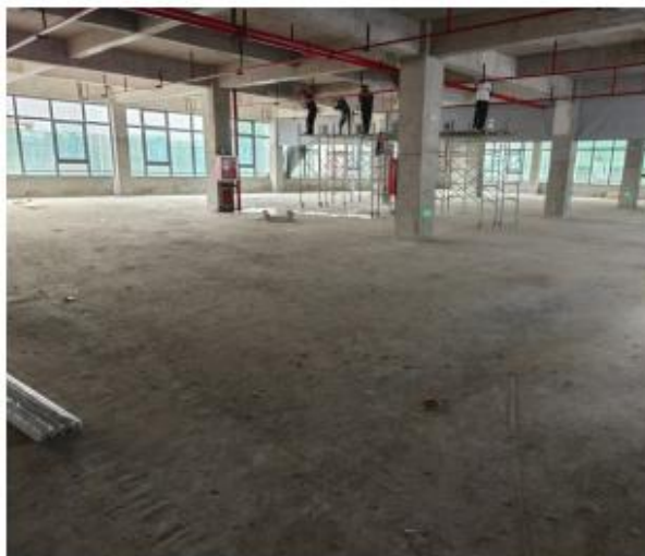
空置厂房现状 503
