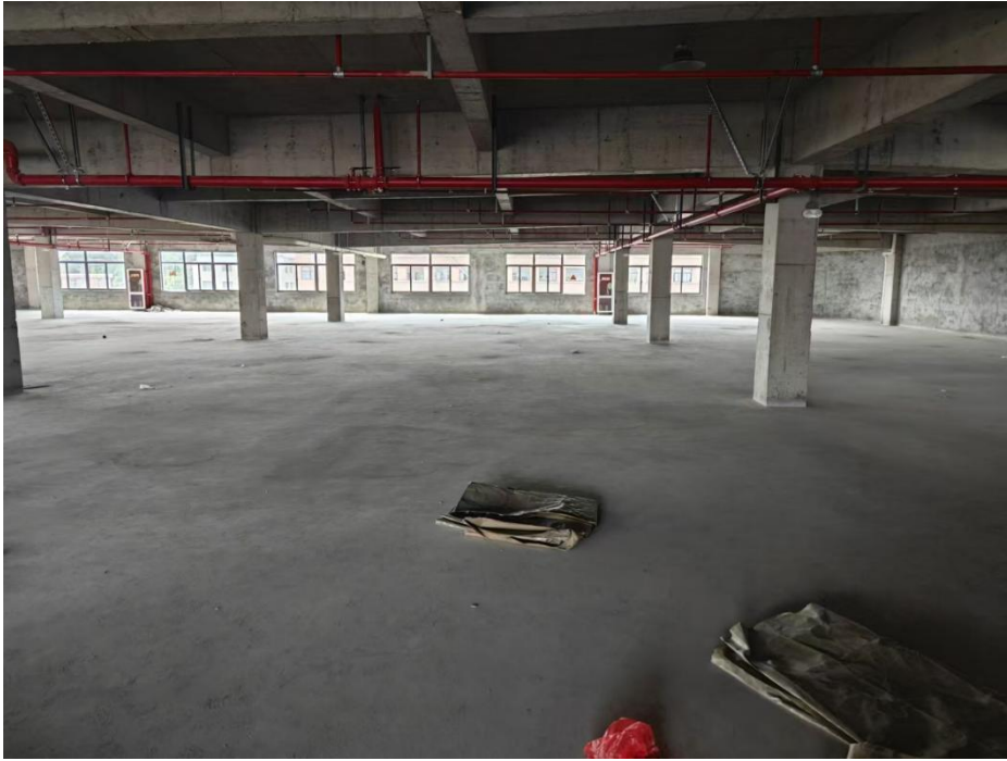
图 2-5 本项目拟使用厂房现状照片
