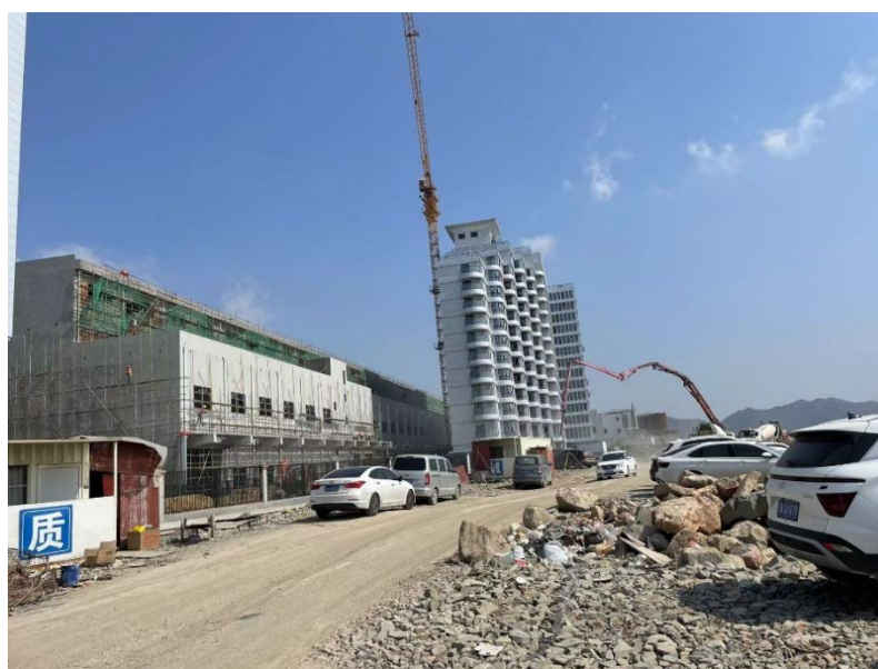
图 3-2 项目现状照片二
