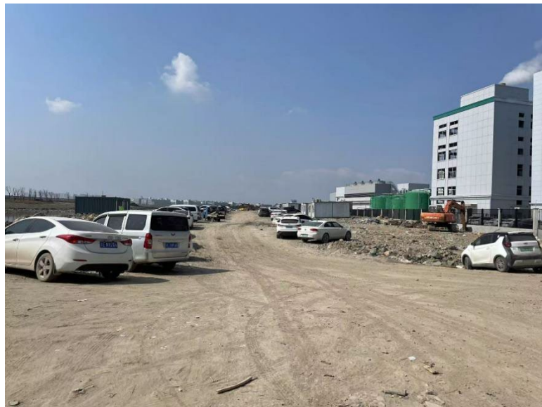
图 3-1 项目现状照片一
