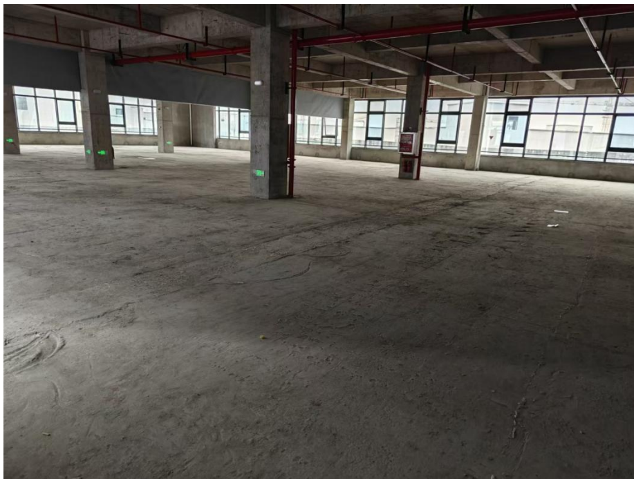
图 2-4 本项目拟使用厂房现状照片
