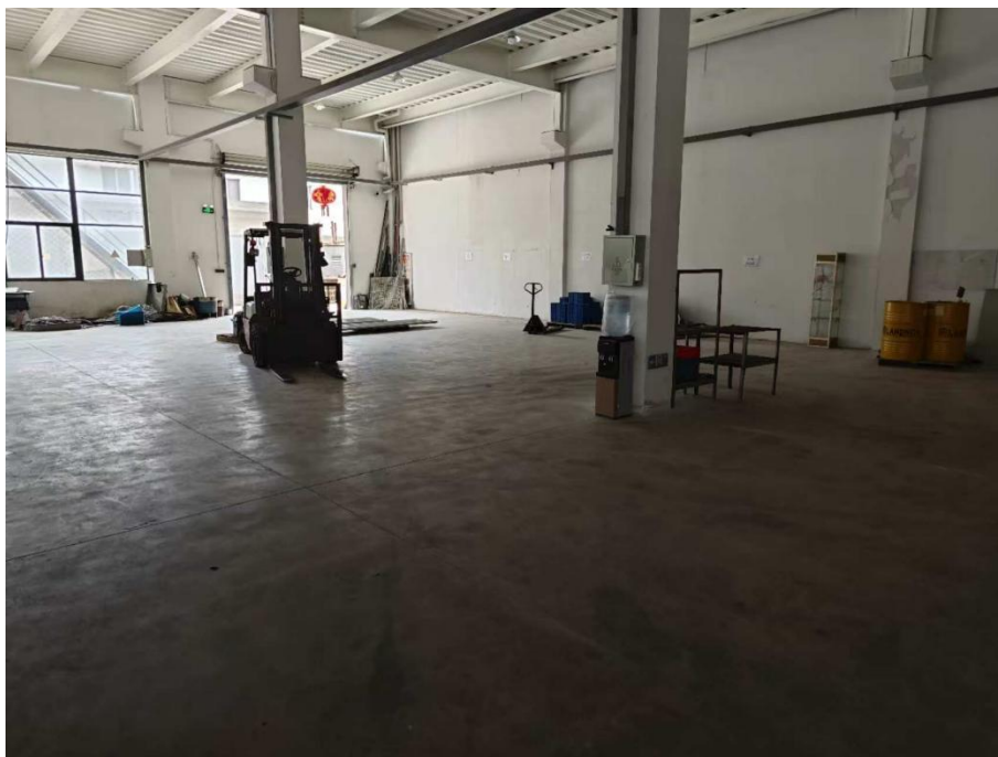
图 2-3 本项目拟使用厂房现状照片
