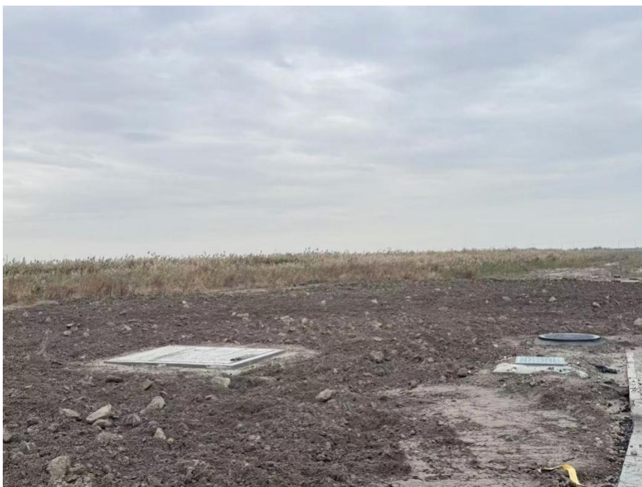
图 2-6 项目厂址照片
