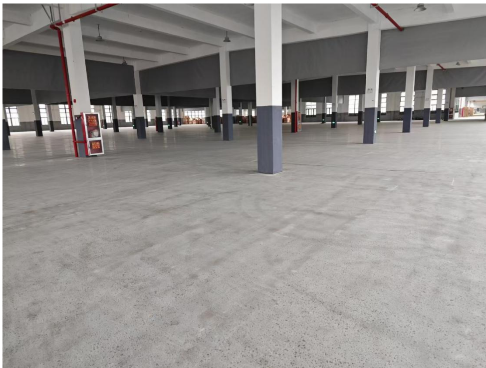
现有空厂房照片
